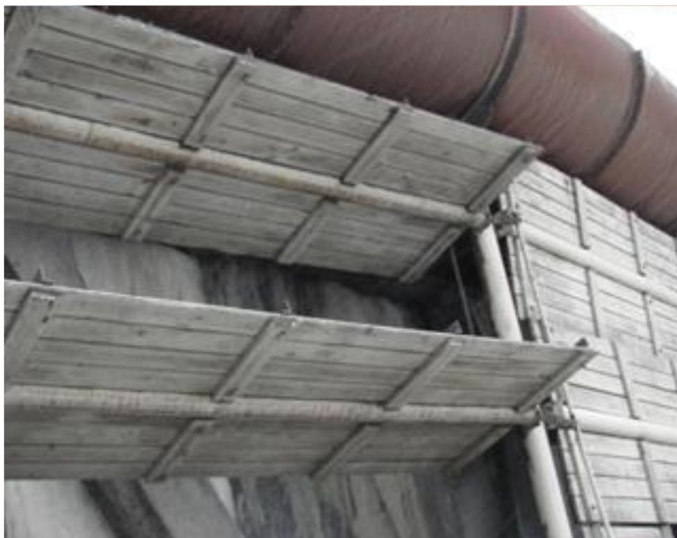
Рисунок 1.11 – Обмерзание входных окон и воздухорегулирующие устройства на них
