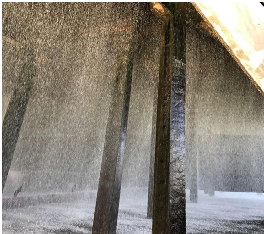
Рис. 5.2. Фотография элементов градирни системы обратного охлаждения Калининградской ТЭЦ-2
