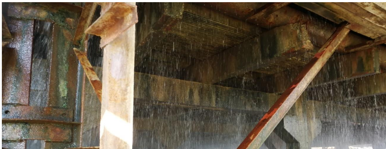
Рис. 4.11. Фотографии биологического обрастания на местах с непостоянным орошающим потоком воды
