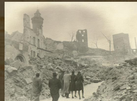
Разрушения в г. Нюрнберг
